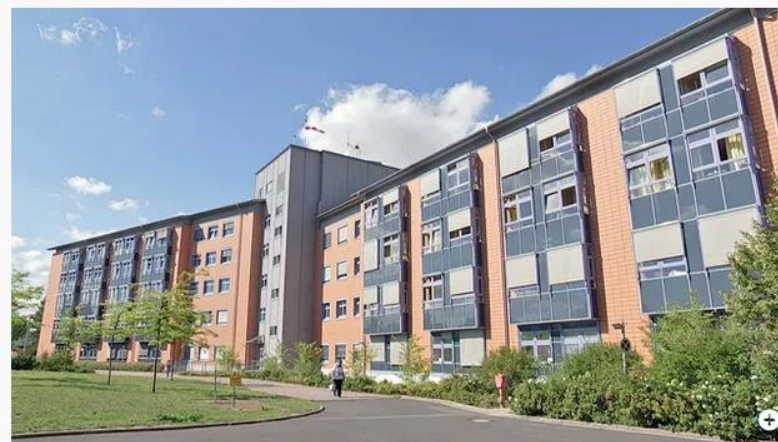
Gebäude des Hufeland-Klinikums in Mühlhausen ...
