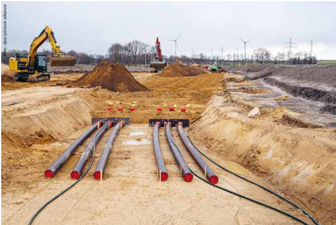
Ein Bauabschnitt der Südlark-Stromtrasse bei Diepholz vor fünf Jahren: Beim Netzausbau wurde viel Zeit verloren.
