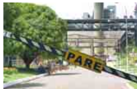
Pare! Halt! Einfahrt zu Alunorte, der weltweit größten Aluminiumoxidfabrik.
